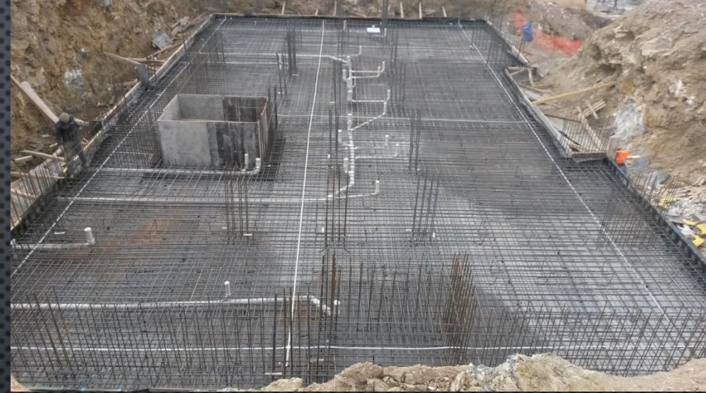
Grobeton ve Donatı İmalatı Tamamlanmış Radye Temel Örneği
