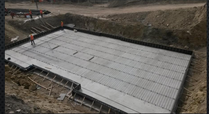
Temel Betonu Dökülmüş Radye Temel Örneği
