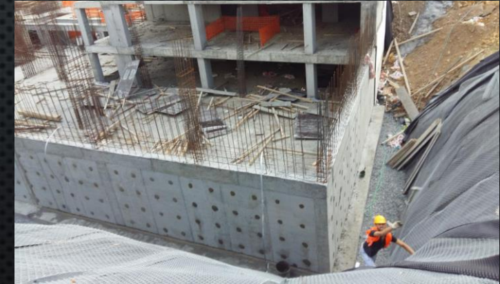
Betonu Tamamlanmış Perde Durumu
