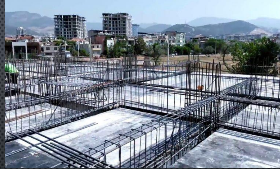
Ters Kirişin Donatılandırılma Durumu
