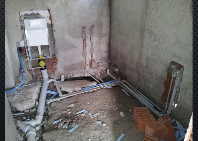
Düşük Döşeme Üstü Tesisat Uygulaması
