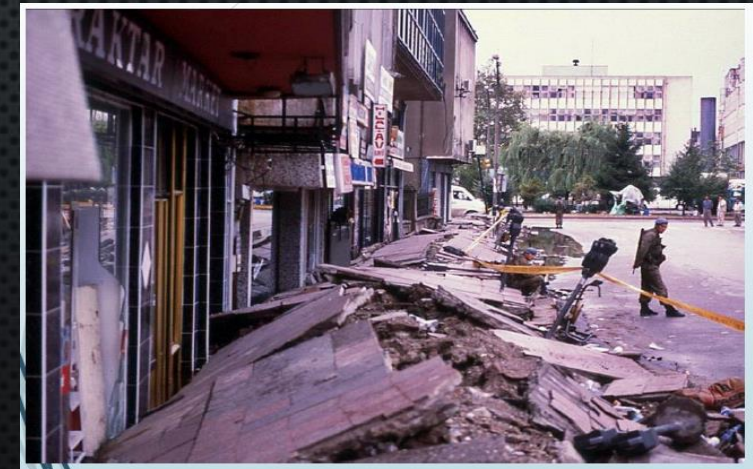
17 Ağustos 1999 Depreminde Zemin Sıvılaşma Örneği
