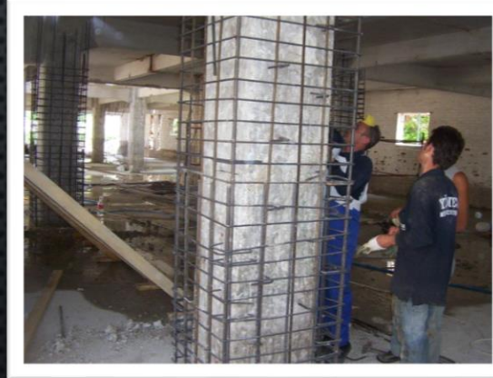
Betonarme Elemanların Güçlendirme Örnekleri
