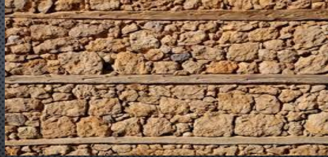
Yığma Yapıda Hatıl Örneği
