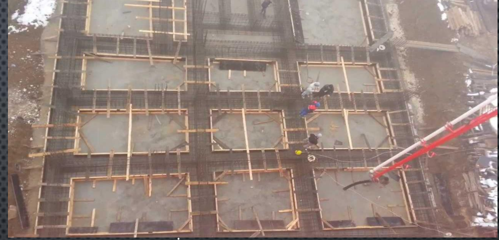
Grobeton ve Donatı İmalatı Tamamlanmış Mütemadi Temel Örneği
