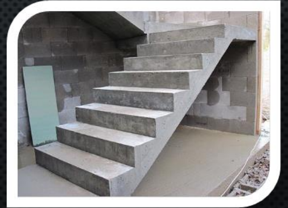
Betonu Tamamlanmış Merdiven
