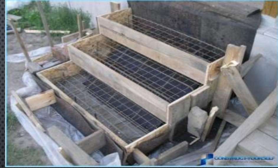
Merdivenin Donatılandırılma Durumu
