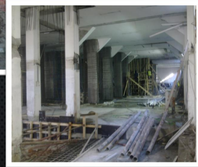
Betonarme Elemanların Güçlendirme Örnekleri
