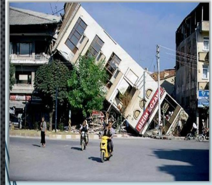
17 Ağustos 1999 Depreminde Sakarya' da Zemin Sıvılaşma Örneği
