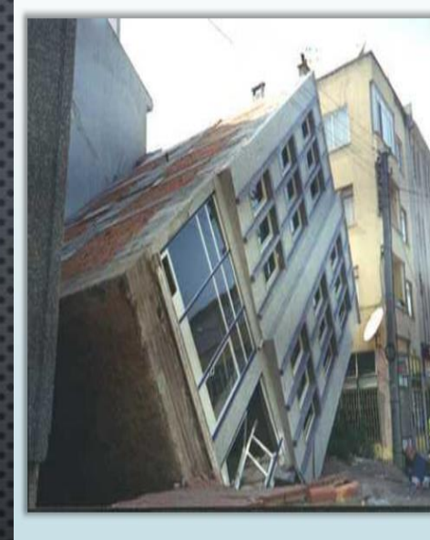
17 Ağustos 1999 Depreminde Sakarya' da Zemin Sıvılaşma Örneği
