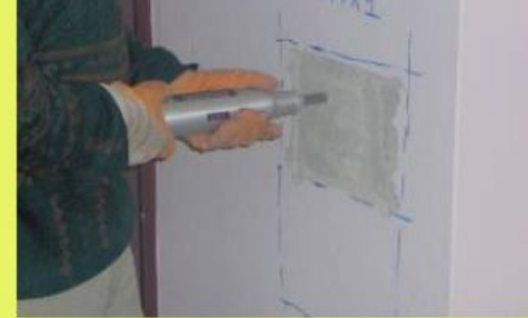
Beton Karot Alımı Öncesi Hazırlık
