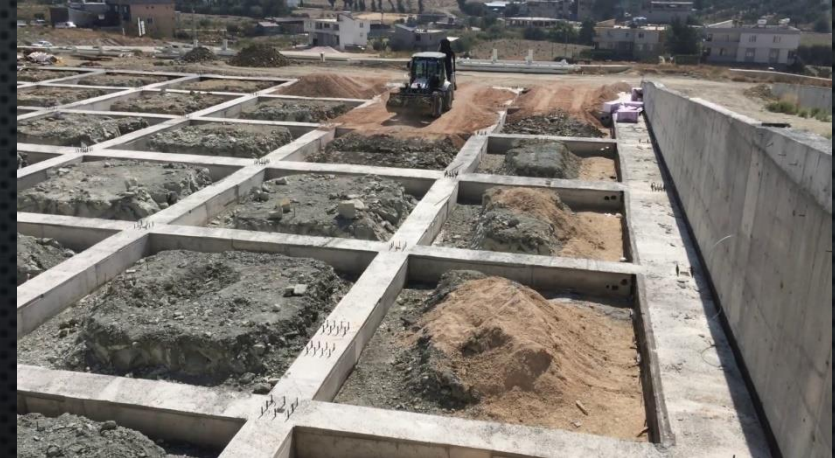
Beton İmalatı Tamamlanmış Mütemadi Temel
