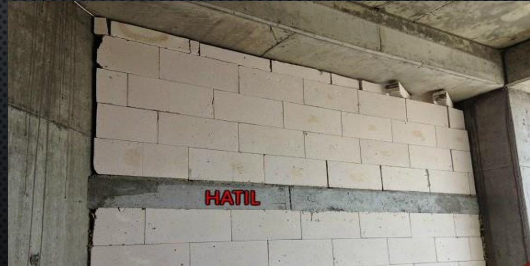
Betonarme Yapıda Hatıl Örneği
